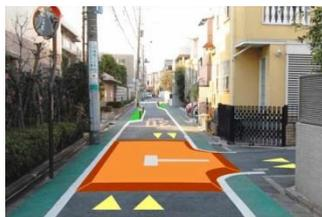
※ハンプとは、道路上に低いカマボコ形の障害物を設けたり、路面の一部を盛り上げて舗装することによって、道路の横断方向に幅3・5m、高さ10・15cm程度の出っ張りを設けることで運転者に減速を促すもの。舗装材で成形したもの他、ゴム等の素材でできた製品を設置する場合もある。また路面に物理的な凹凸をつけず、視覚的な錯覚を利用するイメージハンプという方法もある(左写真)。
