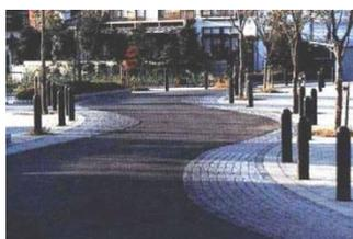
※ボンエルフ(woonerf)とは、生活道路において、車道を蛇行させるなどして自動車の速度を下げさせ、歩行者との共存を図ろうとする道路のこと。その目的は住宅地における人と車の共存である。1960年代後半、都市計画に「歩車分離」の概念が浸透したが、歩行者専用道路の設置には費用及び地形上において制限が存在した。ボンエルフは自動車の速度制限を行うことで、費用及び地形上の制限を軽減し、歩行者の安全という目的を果たすことを意図している。
